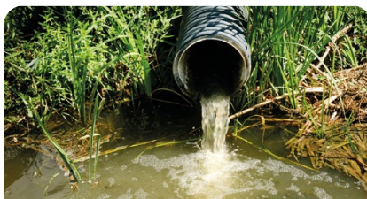
Desechos de aguas residuales
