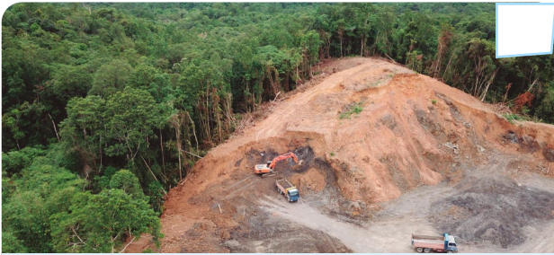
Extracción de tierra en una mina con fines comerciales.
